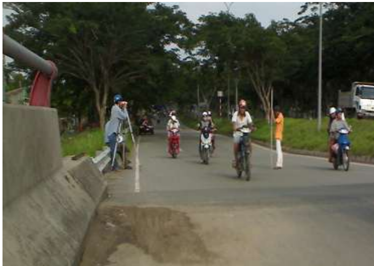
Hình 3.52. Khảo sát đường dẫn vào cầu Xóm Củi – Q.7, Tp.HCM
